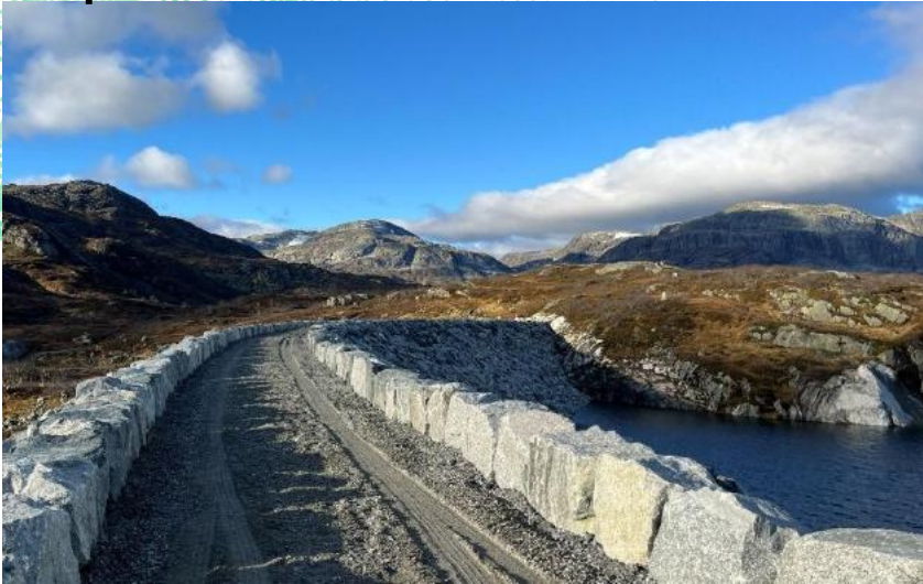
Kjela dammer Asphalt core
