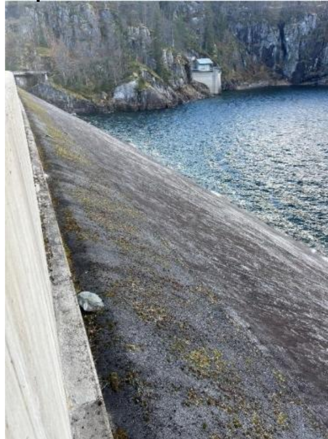
Venemodammen Asphalt Face
